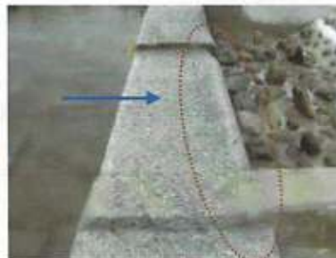
既設床止切欠部のラウンディング 数種の水深パターンの試み (10~20cm)
