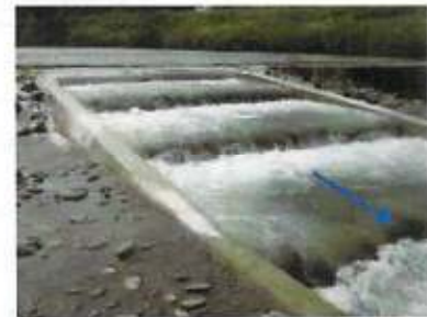
切欠部のラウンディング、玉石の配置により剥離流の発生を抑制
