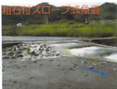
底生魚等を対象にした粗石付スロープ魚道
